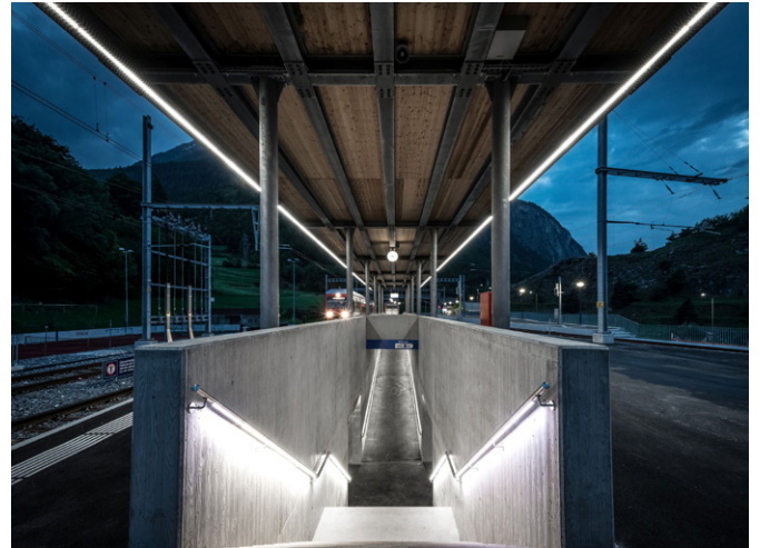
Bahnhof Sembrancher (Decke: LaneLED WALL, Treppenabgang: LaneLED INOX42)
